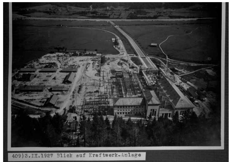
Blick auf das Achenseekraftwerk aus dem Jahr 1927.
