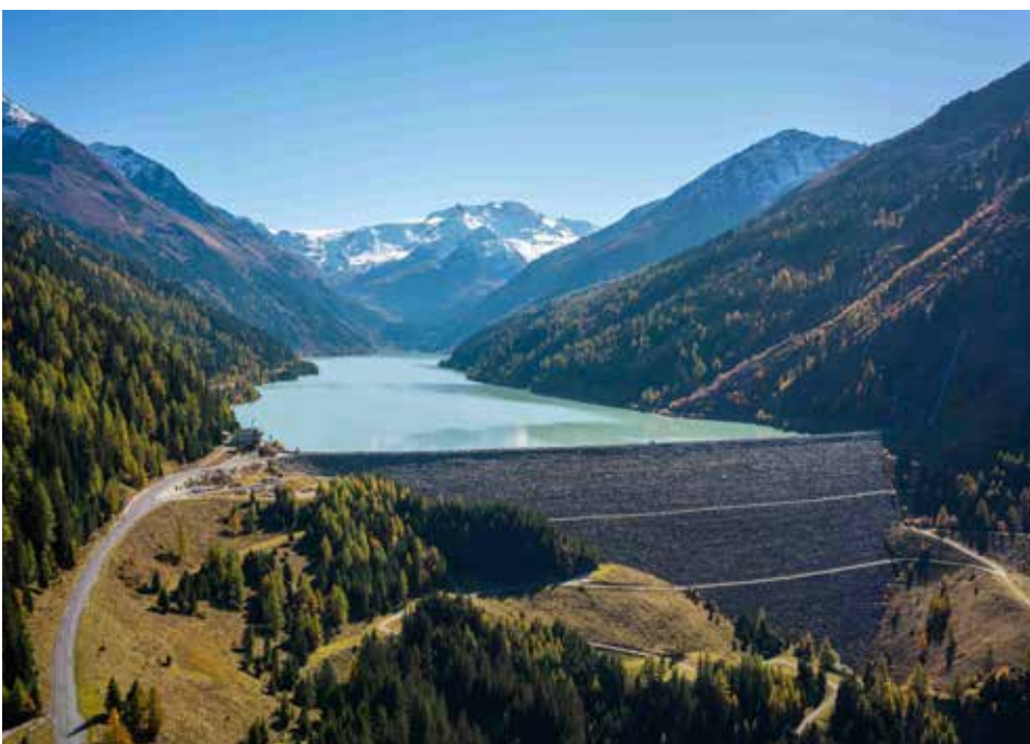
Der bereits bestehende Speicher Gepatsch.
