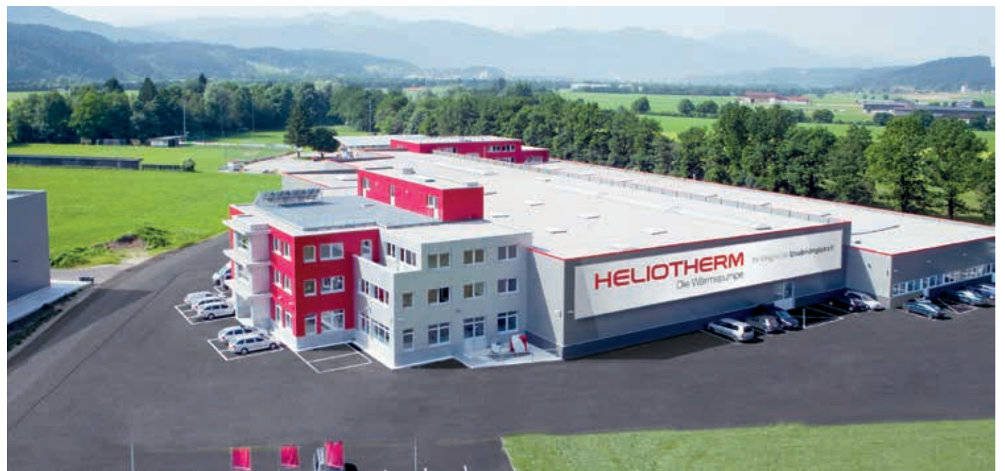
Bei Heliotherm wird seit 35 Jahren an der grünen Energiewende gearbeitet.
